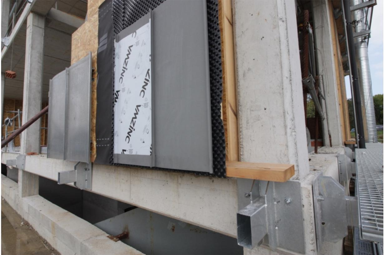
*Figura 13. Fotografía ejecución de cerramiento de fachada.*
