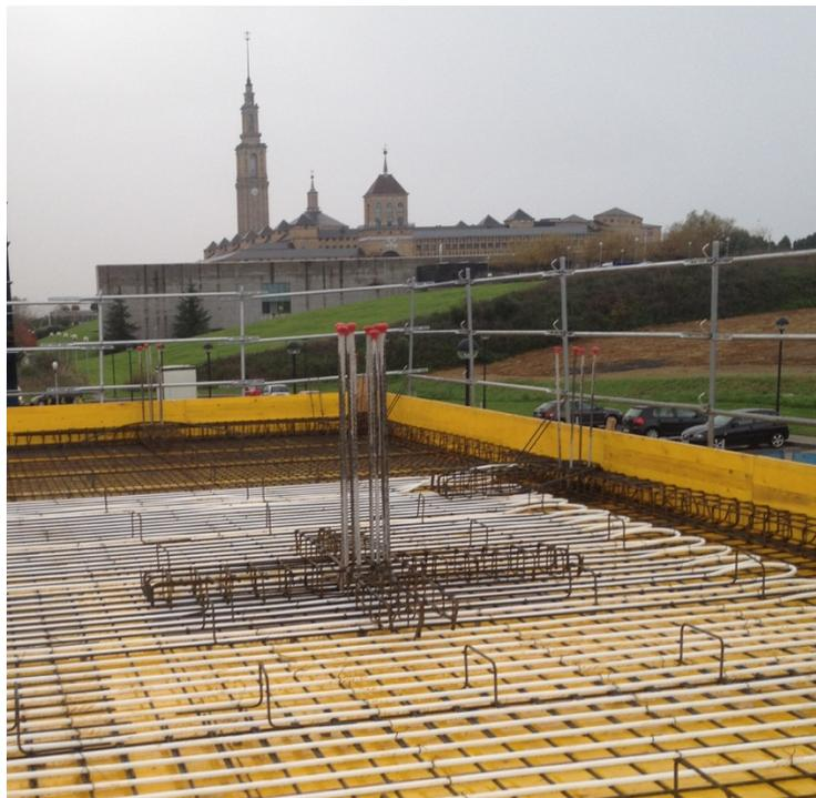
Figura 21. Fotografía ejecución losas de estructura termoactivadas .
