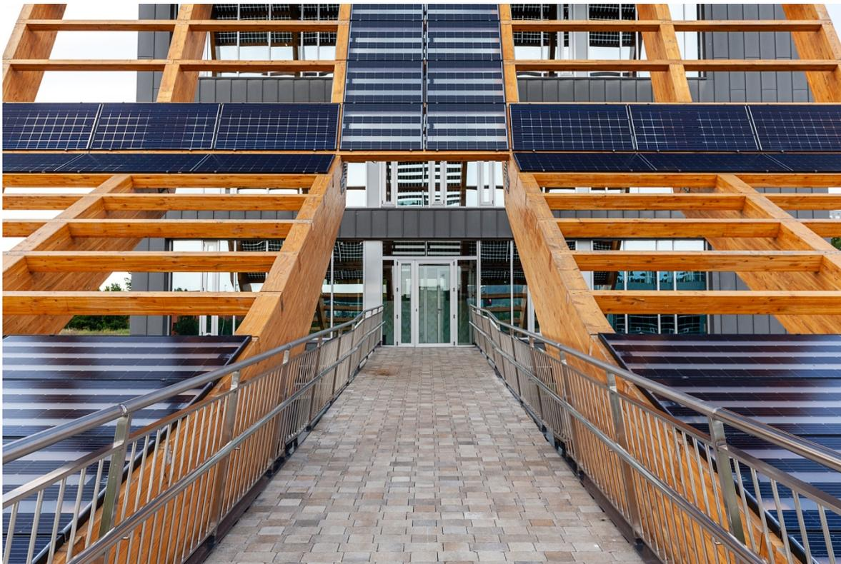
Figura 30. Fotografía paneles fotovoltaicos en fachada sur
