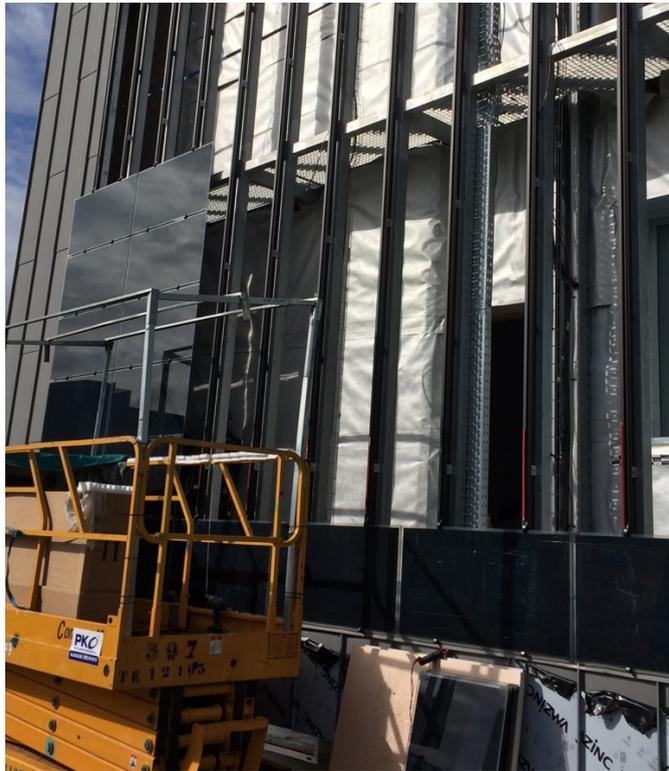
*Figura 16. Fotografía instalación de paneles fotovoltaicos y camara técnica con aislamiento exterior en el cerramiento de fachada.*
